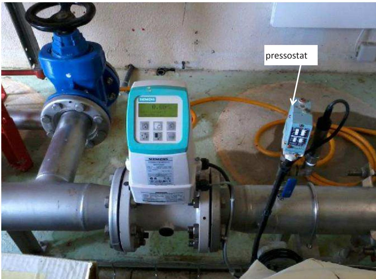
Photographie n° 5 : vue des dispositifs de surveillance de la station de pompage du captage de Cheroute (Source : Terraqua, le 12/04/2018)
