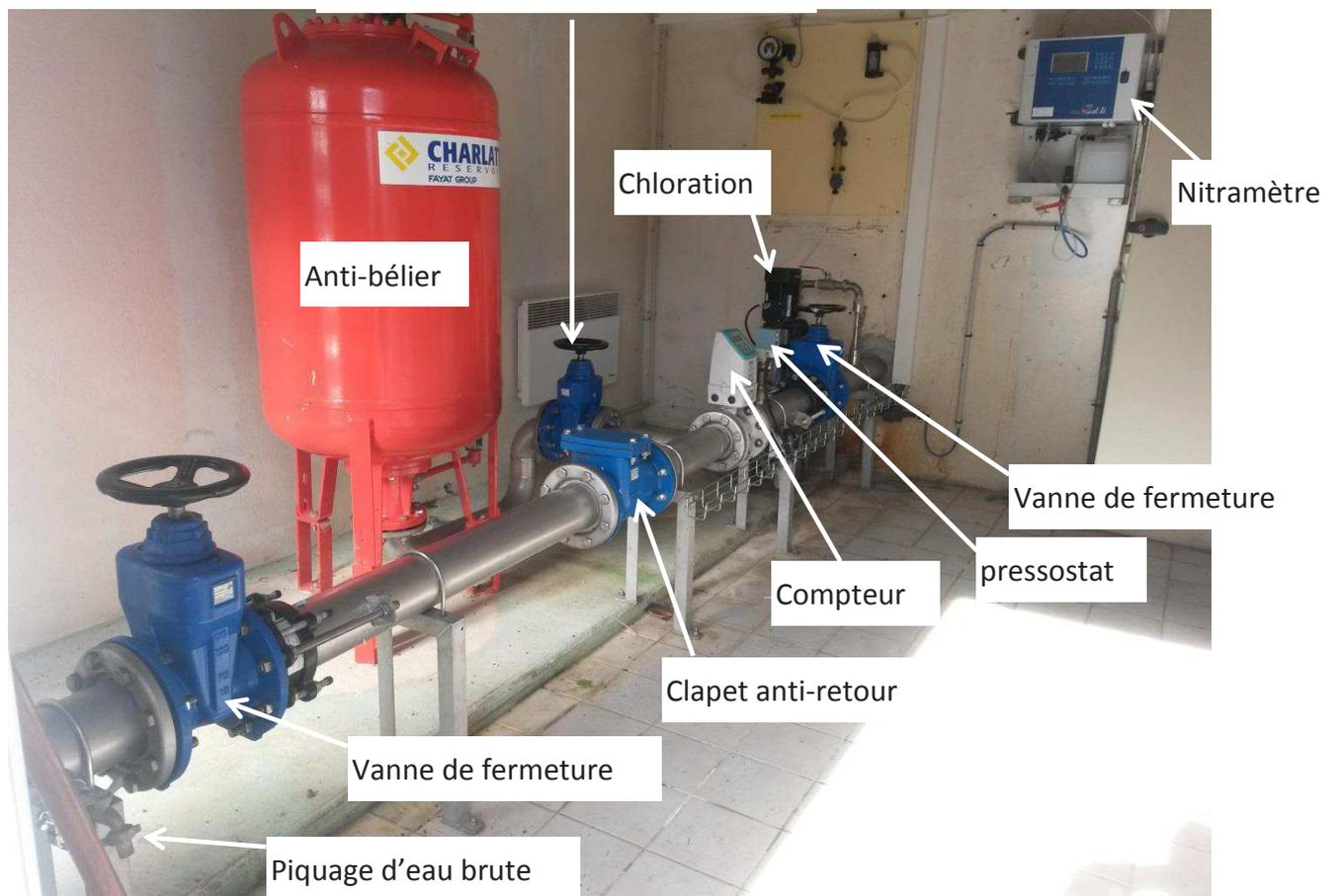
Photographie n° 4 : vue d'ensemble de la station de pompage du captage de Cheroute (Source : Terraqua, le 28/09/2017)
