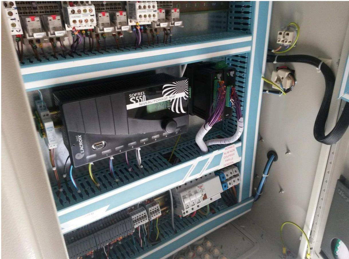
Photographie n° 6 : vue du dispositif de télésurveillance de la station de pompage du captage de Cheroute (Source : Terraqua, le 28/09/2017)
